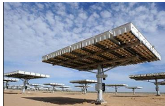
Bild 2: Chinesische Spitzentechnologie: CPV-Konzentratorzellen auf zweiachsigen Solartrackern Wiki.
